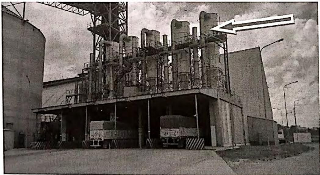
Sistema de aspiración y filtrado de polvo de las cabinas de descarga de granos.
